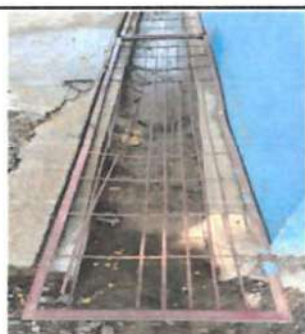
Foto 5: CUNETA DE CONCRETO
