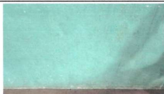
Foto 4: PINTURA EN MUROS INTERIOR Y EXTERIOR
