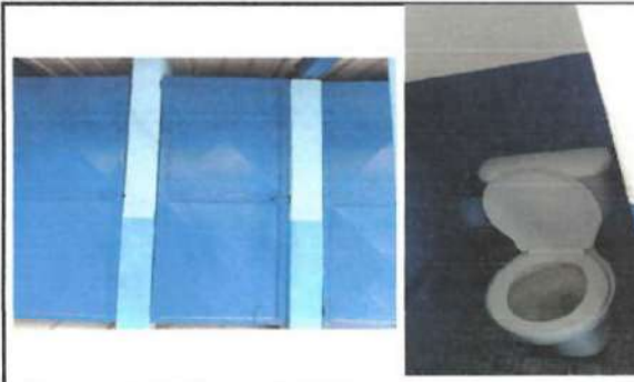
Foto 4: SERVICIOS SANITARIOS Y SUS ACCESORIOS
